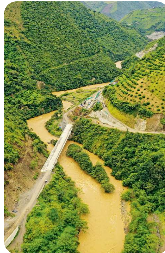
La construcción de las distintas obras avanza de manera simultánea.
