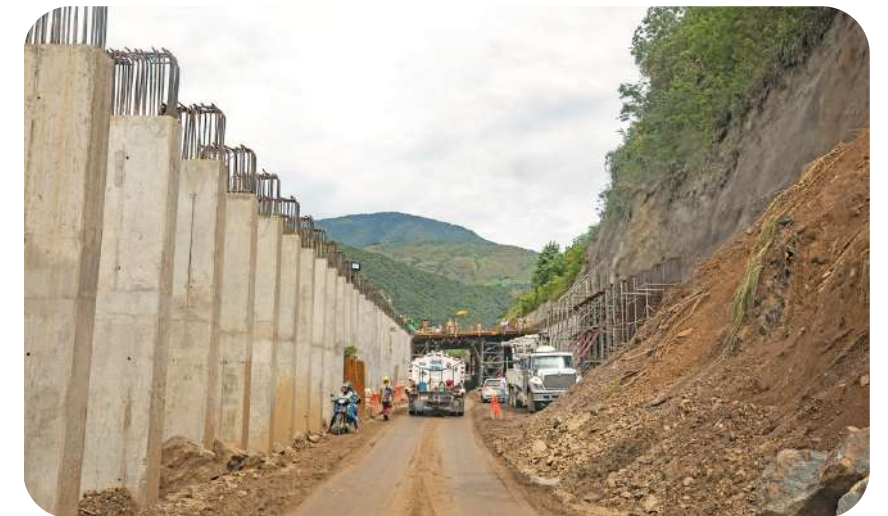
Proceso de construcción de la conexión con el mar.
