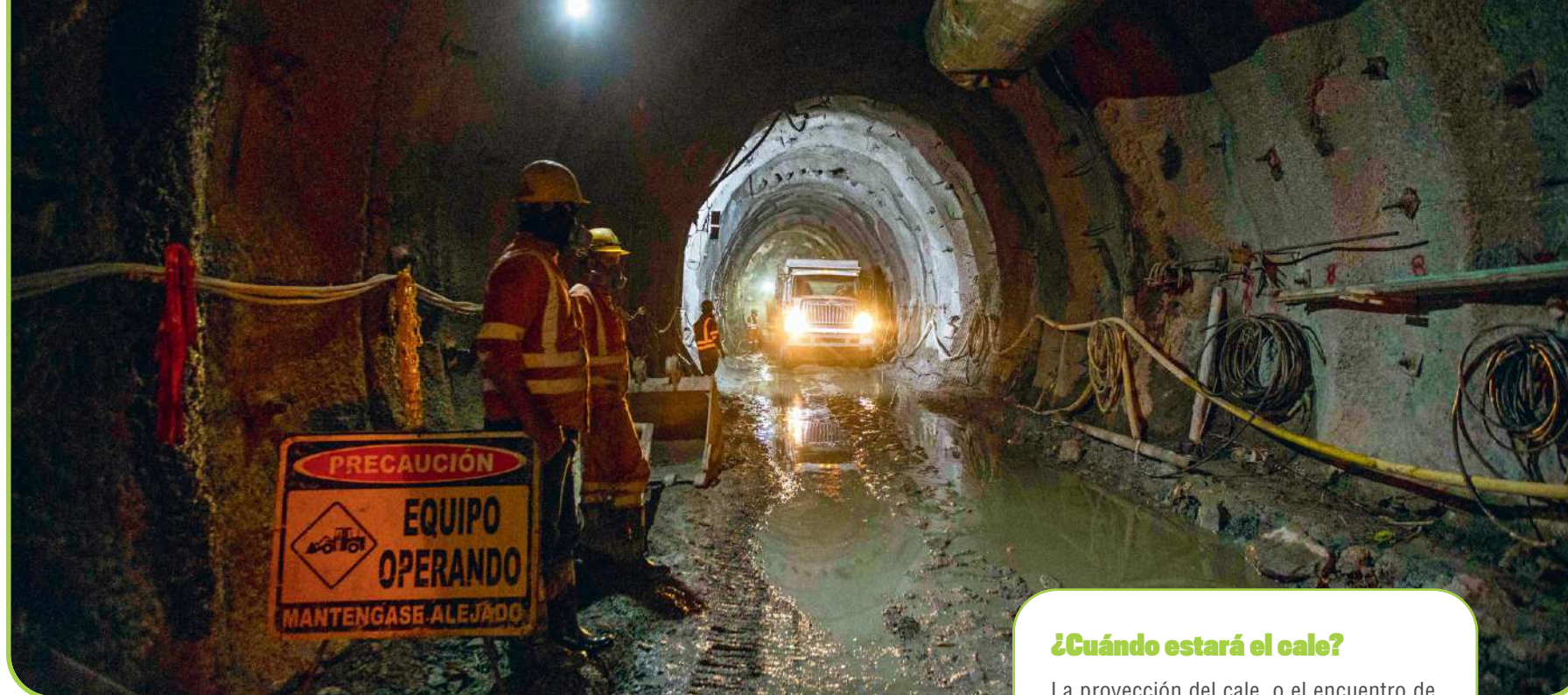
La galería de rescate es 100 metros más larga que el túnel principal.
